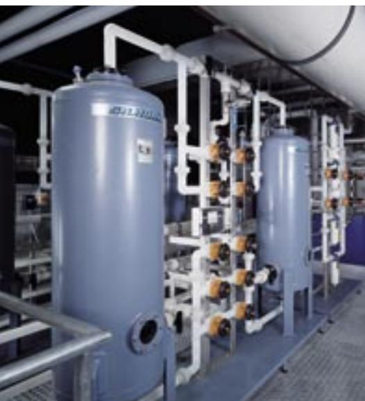
Moderne Wasseraufbereitungsanlage für die Versorgung mit ultrareinem Wasser. Dieses Wasser wird bei der Produktion von Halbleitern und Lichtleiterkomponenten verwendet.
